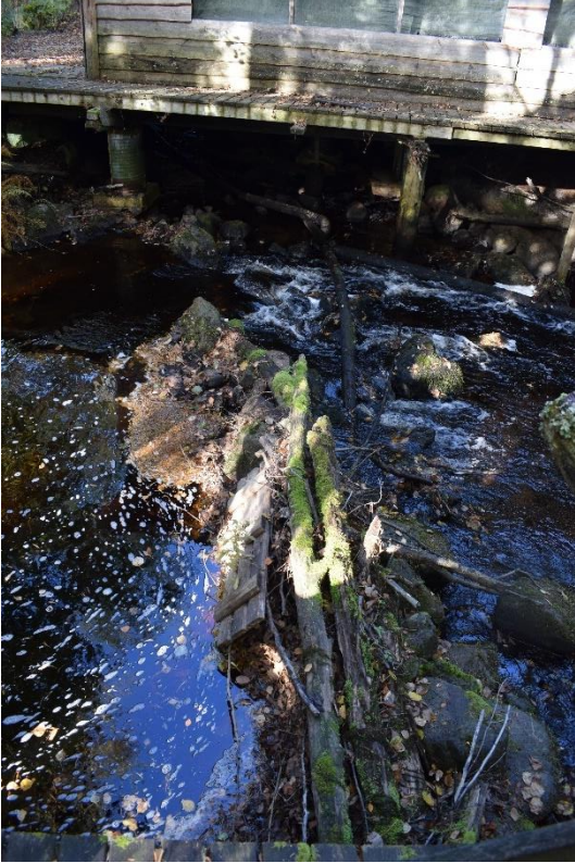
Kuva 10. Kivi- ja puumateriaalista tehty valli.
