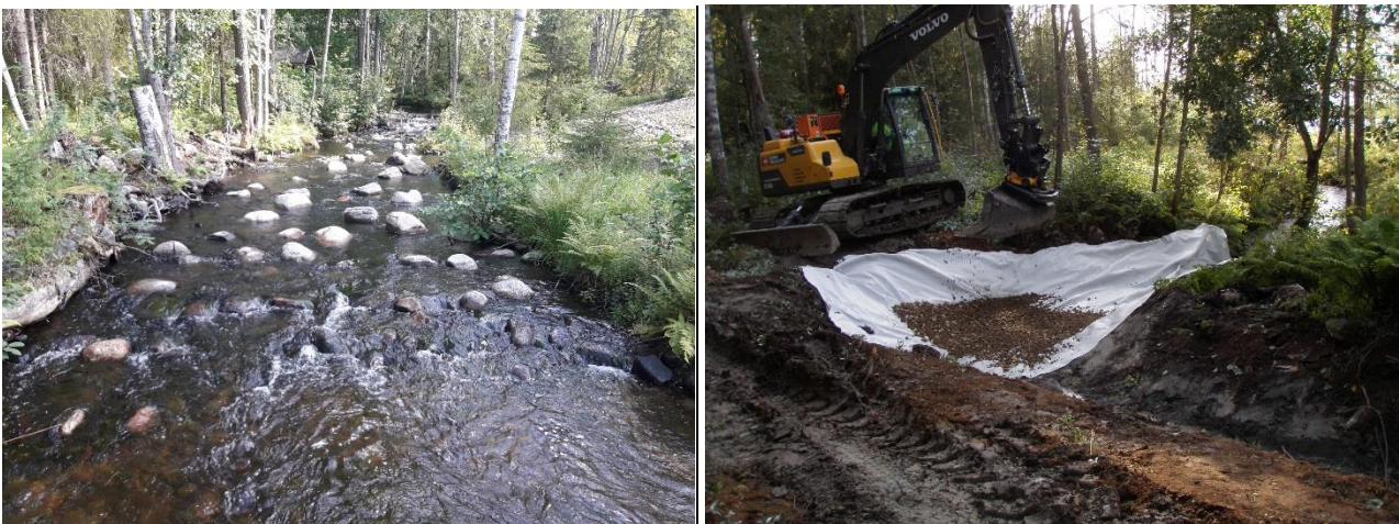
Kuva 17. Martinojan yläosan koelaa (vas.) sekä kalatien rakentamista v. 2015 alemman padon ohitse
